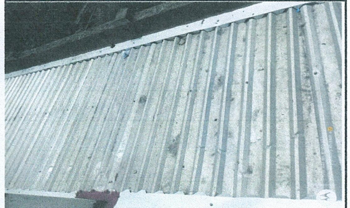
Foto 2: Mejoramiento de estructura tipo potico e instalacion de lamina troquelada calibre 16.
