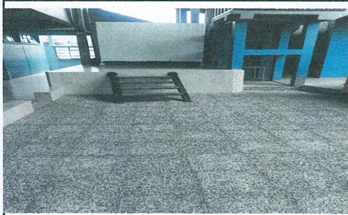
Foto 1: Mejoramiento de piso tipo granito en corredor y escenario.
